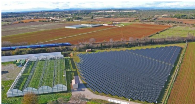
Centrale Solaire de LUNEL LUNEL (34)
