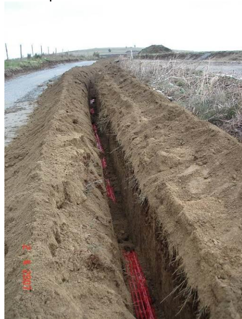
Réalisation de la tranchée et de la pose du câble simultanément
